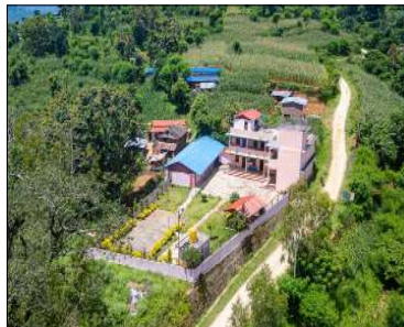
१ नं. वडा कार्यालयको प्रशासनिक भवन
